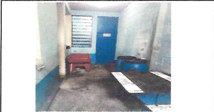
Foto 1: Se presenta cocina, pared por falta de azulejo las paredes se humedecen piso en mal estado
